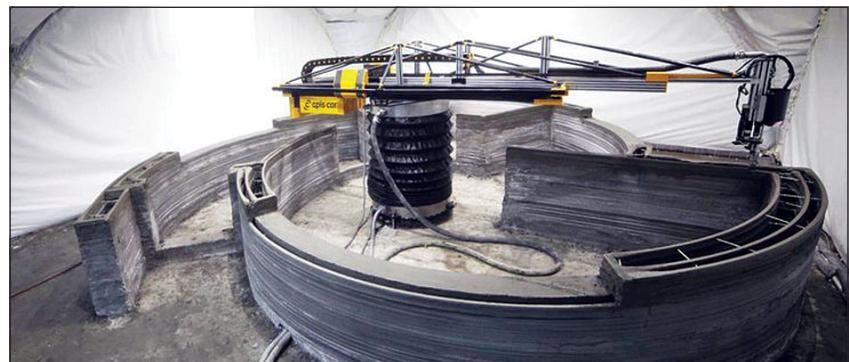
**Рис. 5. Возвведение офисного здания в г. Ступино по технологии мобильной строительной 3D-печати, Apis Cor, Россия, 2017 г.** [12]
