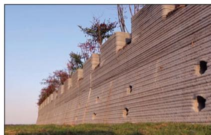
**Рис. 10.** Самая длинная в мире напечатанная конструкция, Китай, 2019 г. [19]
