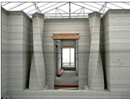
**Рис. 4. Печать одноэтажного здания отеля на строительной площадке, Total Kustom, Филиппины, 2015 г.** [11]
