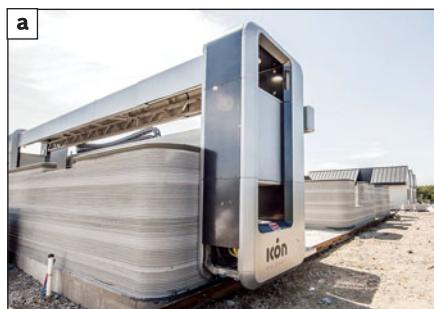
**Рис. 35.** Процесс печати с помощью принтера ICON типовых жилых домов для бездомных (а) и вид построенных домов (б) в Техасе, США [48]
