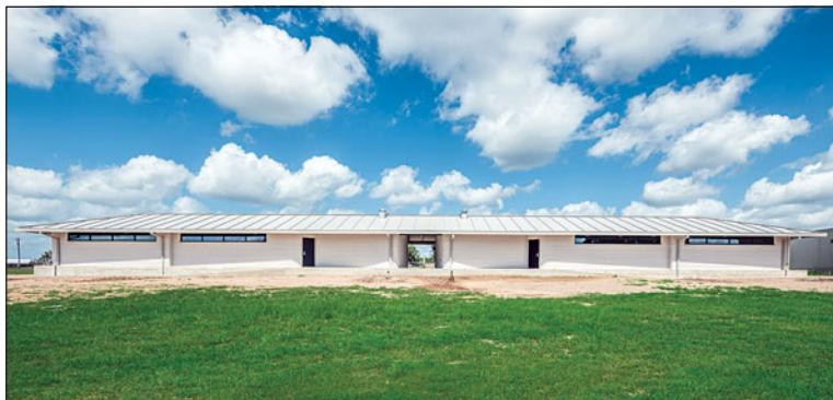
**Рис. 18. Тренировочные казармы в учебном центре Кэмп-Свифт в штате Техас, возведенные с использованием строительного 3D-принтера, США, 2021 г. [28]**
