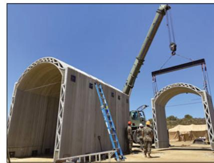
**Рис. 17. Сборка ангаров для военной техники из конструкций, изготовленных в полевых условиях с использованием строительного 3D-принтера, США, 2020 г. [27]**
